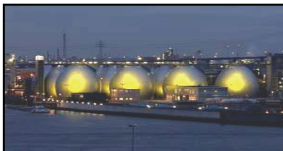
Klärwerk Köhlbrandhäft, zu sehen gegenüber der ehemaligen Englandfähre.
