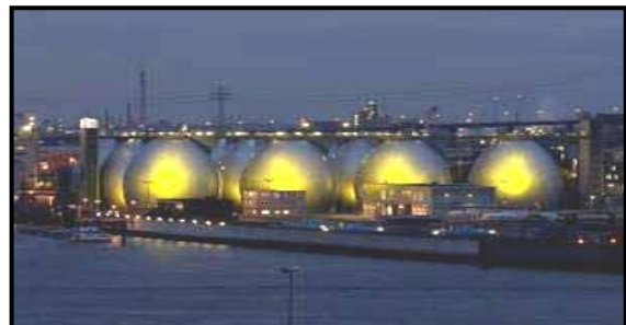
Klärwerk Köhlbrandhäft, zu sehen gegenüber der ehemaligen Englandfähre.
