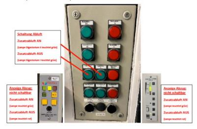
Aus Gründen der Energieeinsparung schalten Sie die Zusatzabluft nach Beendigung der Arbeiten wieder aus (Zusatzabluft AUS)!
