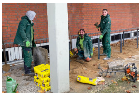
Am 19. November 2024 wurde mit den Arbeiten begonnen, leider sind bislang nur hier und am Martin-Luther-King-Platz überdachte Stellplätze möglich.
