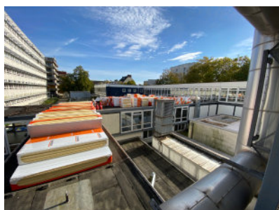
Die Wärmedämmung liegt bereit. Hoffentlich wird sie in den kommenden Sommern auch etwas Linderung bzgl. des Wärmeeintrags bringen. (Fotos: Norbert Boßlar)
