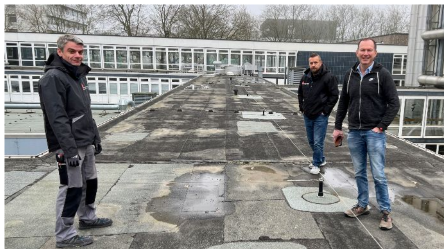
Stephan Brand und Jens Ihde von der Haustechnik mit Fachbereichsleiter Markus Fischer bei der Inspektion des Flickenteppichs.
