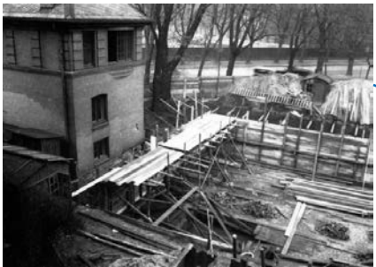
Abb. 4: Der Bau des Instituts für Physikalische Chemie. Blick aus dem Physikalischen Staatsinstitut.
