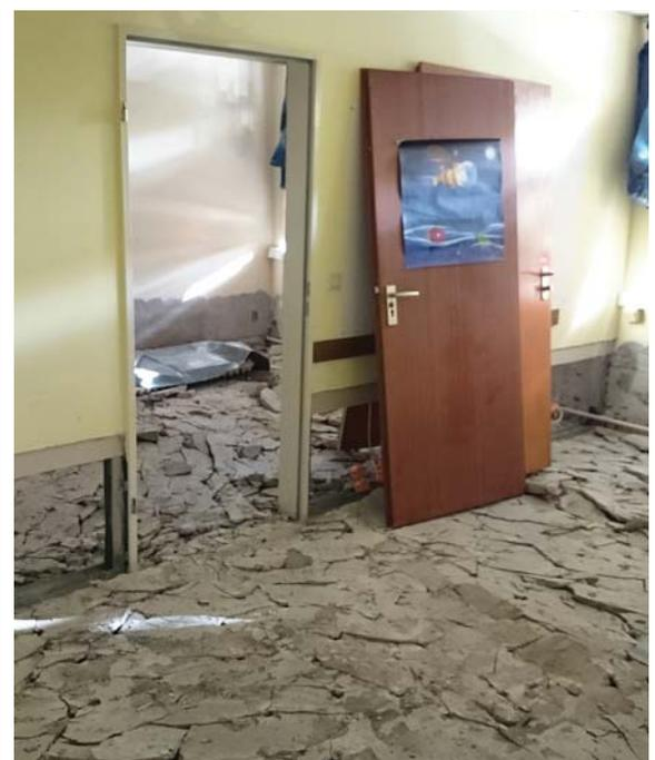
Sanierung der Büros. Fußboden und Wände werden bis 50 cm Höhe erneuert.
