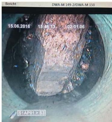
Fotoaufnahme der Kamerafahrt: Ein Stein verschließt den Kanal, Schlamm blockiert den Abfluss
